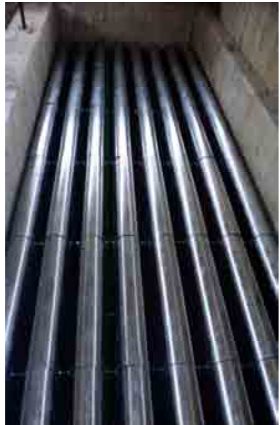
通风断面 7x3 米，大片式，垂直安装，
