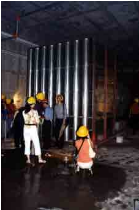
通风断面 4.5x4.5 米，带壳体，积木式，水平安装
