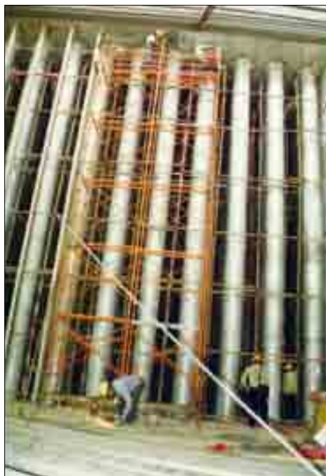
某航空发动机试车台消声装置实景照片
