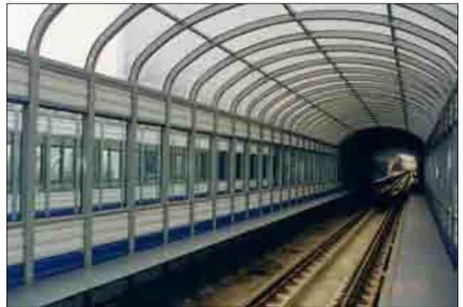
北京城铁西段封闭式声屏障，我公司承担工艺设计、声学构件制作、安装指导
