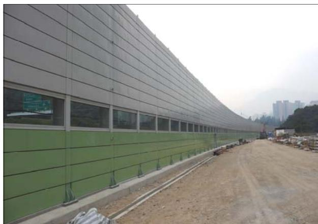
香港机场铁路东涌段，FSL型声盾板，2006年建成
