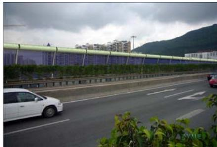
在声屏障顶端设置强吸声体，可以使声屏障在高度不变的情况下形成更大的声影区，提高降噪效果，同时也可以使声屏障外观多样化。
