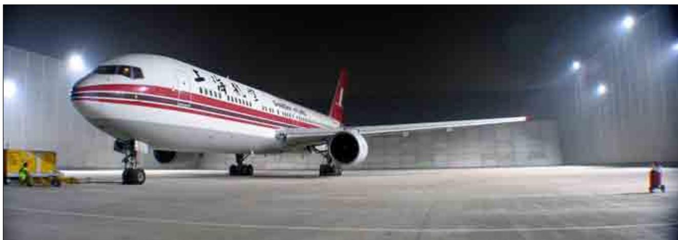
厦门太古飞机试车坪，FS+型声盾板，高度16米，2005年建成
