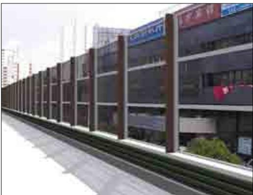
G 在型钢立柱上安装纵向吸声体，如左图所示
