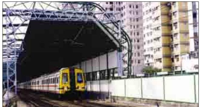
九广铁路上水站段，FSL型声盾板，设吸声体，高度3500毫米，1996年建成
