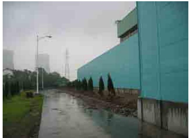
长兴电厂卸煤场，WL型声盾板，无吸声体，高度6000毫米，2005年建成
