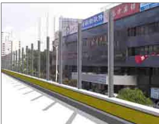
D 在防撞栏上安装防水吸声填料，如左图所示
