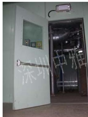
可在短时间内将隔声罩拆掉，进行机组的维护；维护完机组，可以很快装好隔声罩，以免影响电厂正常运作。快速拆装的特征是：采用模块化隔声板，每块隔声板可单独拆卸、吊装；大型构件上均安有吊具；隔声罩顶部的隔声板、集气罩用快速连接装置，便于快速拆卸。
